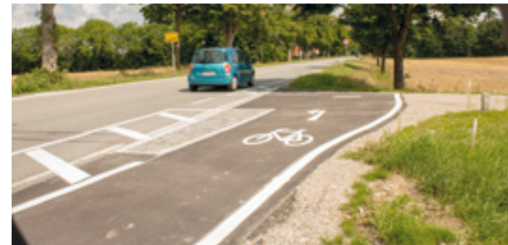
Der Radweg durch Dirnismaning wurde durch die Stadt Garching ertüchtigt. Schluss mit dem Gehoppel über den Bürgersteig! Was hier noch helfen würde: Eine Mittelinsel, um das Überqueren zu erleichtern.
